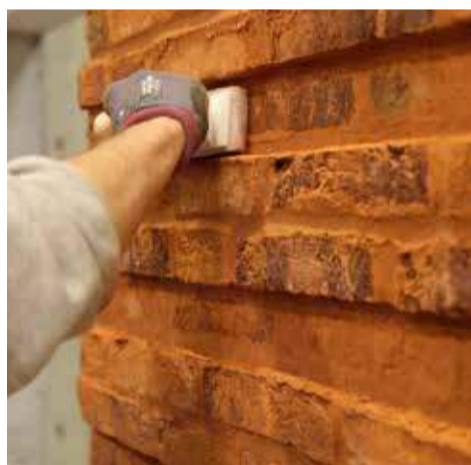
Murværket afrenses umiddelbart efter opmuring.
