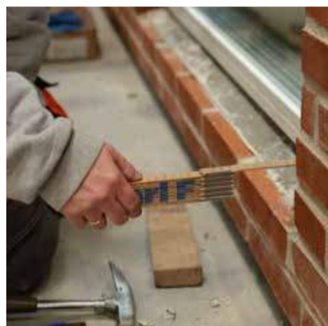
Vinduer kontrolmåles i forbindelse med kvalitetskontrollen.
