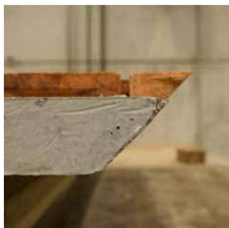
Forskellige hjørneløsninger – som her en samling i smig - er mulige i murstensfacadeelementer.
